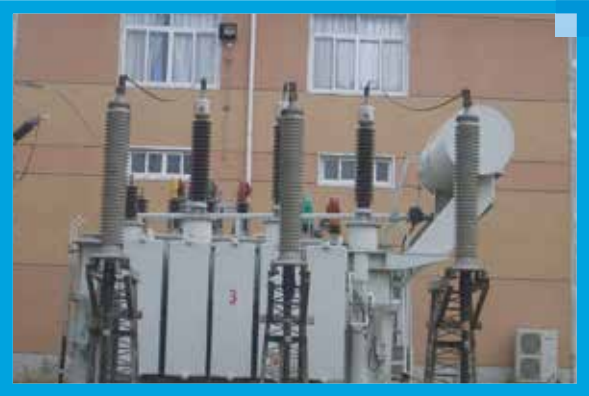
第二代充油式合成绝缘电缆户外终端 TS123-II
