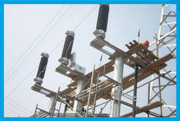
第二代充油式瓷套绝缘电缆户外终端 TP123-II
