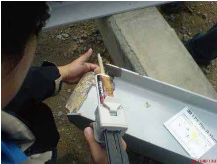
图4:手持式3M™ EPX™ Plus II敷抹器带有一个duo-pak包装管及附在盒子上的静态混合嘴。
