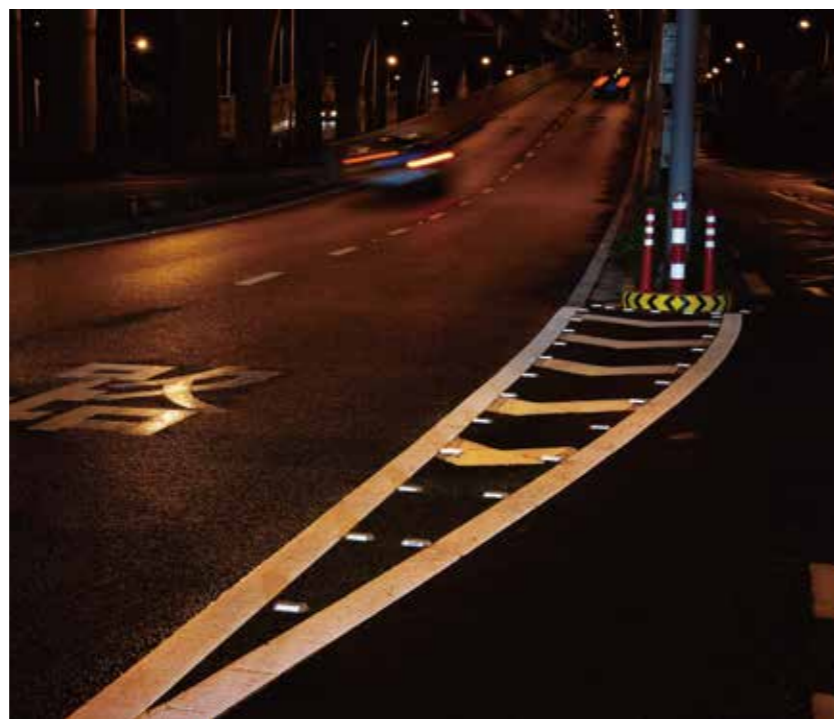
快速路端头 突起路标和标线带亮化
